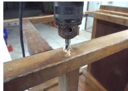
圖 5-10 最後做 80mm 木釘補強 (C6D6)
