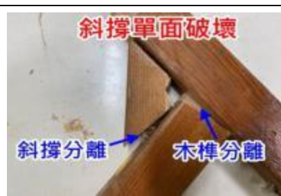
圖 4-18 斜撐單面破壞情況
